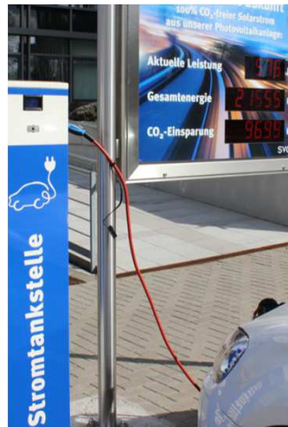
2x Typ 2 bis 11/22 kW 2x Schuko bis 2,3 kW
