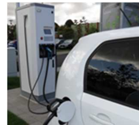
1x CCS 20 kW 1x CHAdeMO 20 kW 1x Typ 2 22 kW
